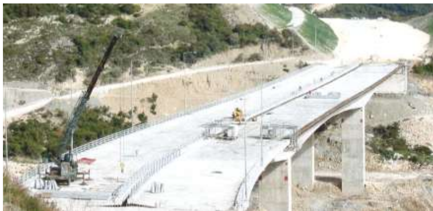
Γέφυρα Μεσοβουνίου μετά την ολοκλήρωση της ανωδομής
